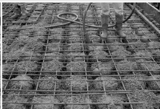
۵. بتن ریزی اولیه
