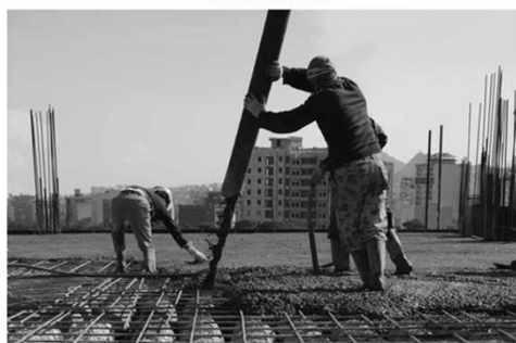
بتن ریزی و ویبره
