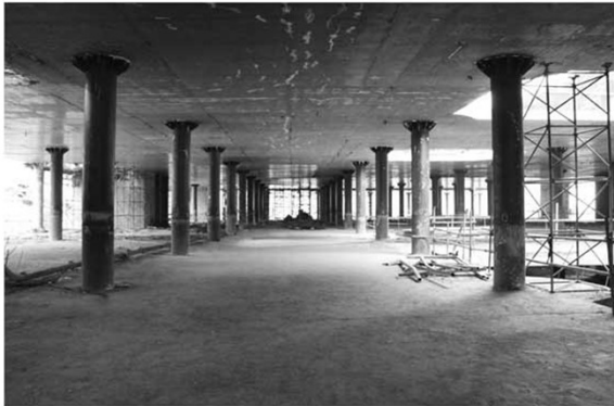
باز کردن قالب
