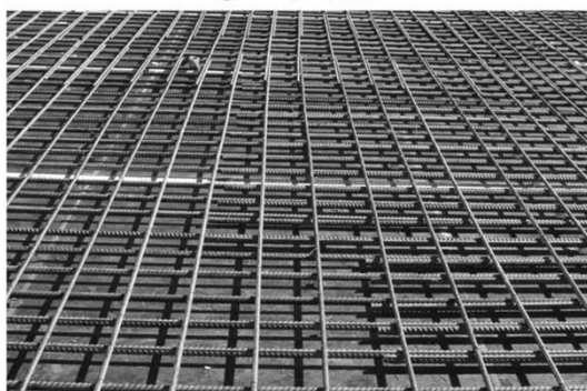
اجرای مش تحتانی
